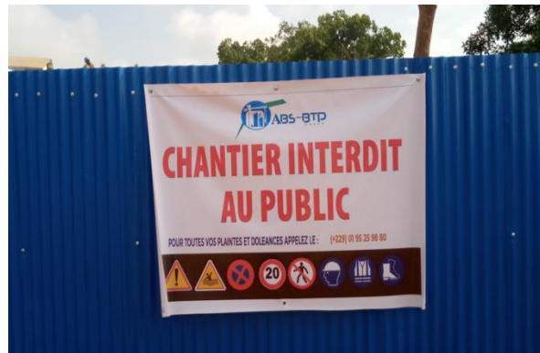
Photo : Barrière physique sur le chantier pour sécuriser le site
