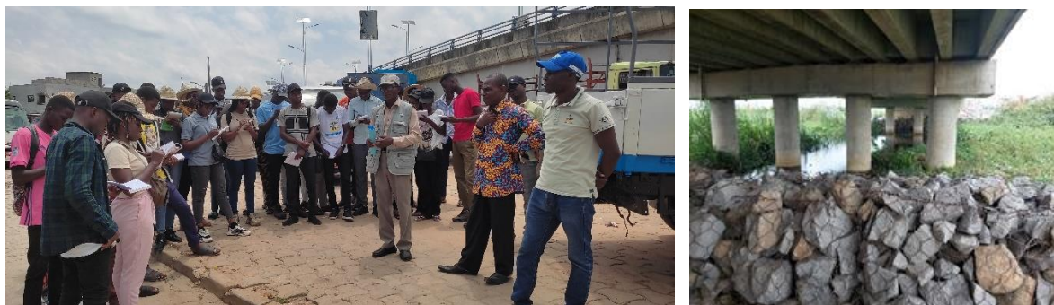
Planche 1 : Échanges sur l'ouvrage en place (à gauche) et une murette de pierres contre le débordement des eaux pluviales (à droite).
