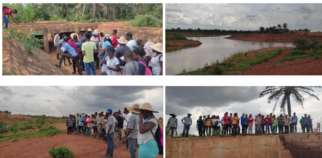
Planche 9 : Séance d'explication au niveau de l'ouvrage de canalisation des eaux pluviales, la vue de profil des réservoirs d'eau et le dégrilleur installé en amont du bassin tampon. Source : ALOFA, mai 2024
