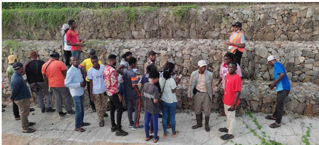
Photo 7 : Protection des berges par des gabions Source : ALOFA, mai 2024
