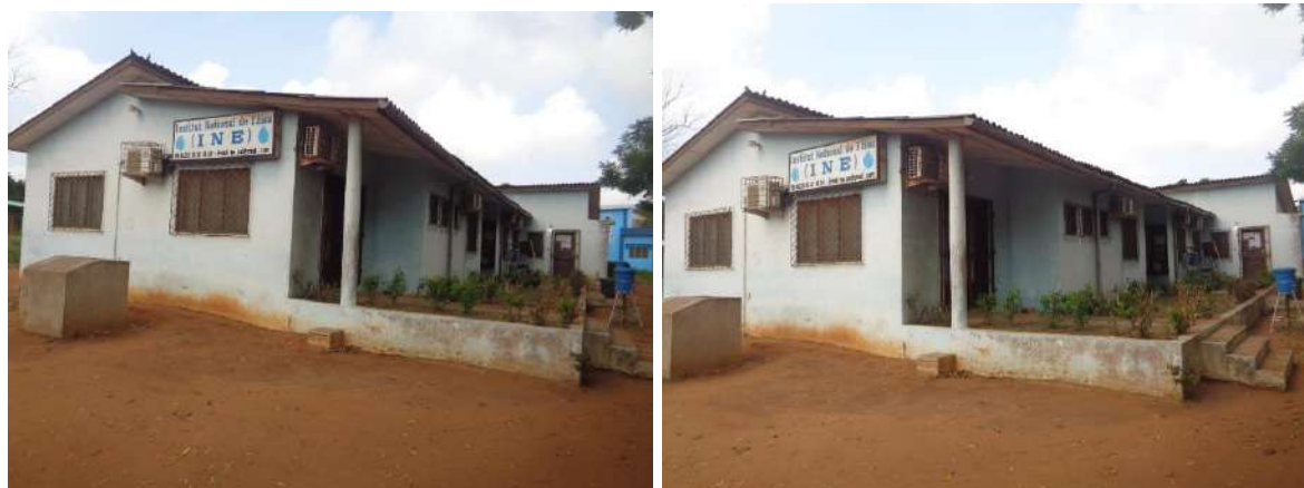
Planche 7 : Bâtiment administratif actuel de l'INE
