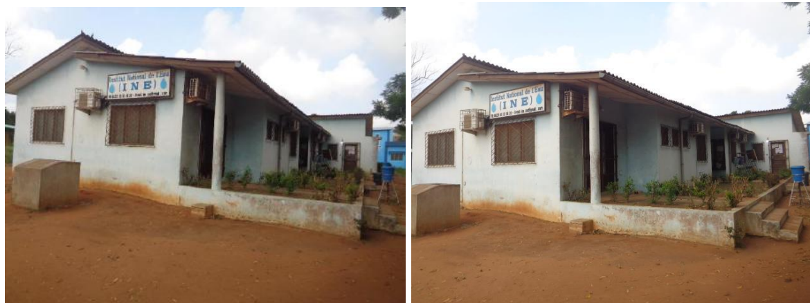
Planche 7 : Bâtiment administratif actuel de l'INE
